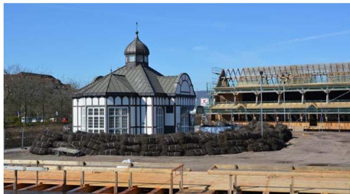
Um den Reisig-Einbau möglichst rasch zu realisieren, wurde der Holz-Aufbau mit den Reisig-relevanten Bereichen der Ostwand-Konstruktion begonnen. Erst danach erfolgt die Anbindung an den Mittelbau. Unmittelbar mit dem Gebinde-Aufbau wird das Reisig eingebaut. Zimmerleute und Reisig-Einbauer arbeiten „Hand in Hand“. So soll vermieden werden, dass das Reisig austrocknet und porös wird.
