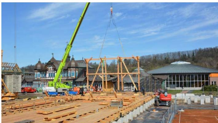
Deshalb unterstützt ein zweiter Kran den Aufbau. Am 11. April wurde das erste Ostwand-Gebinde aufgestellt. Weitere fügen sich nach und nach über die gesamte Länge hinzu. Fast täglich gibt es Weiterentwicklungen zu entdecken.
