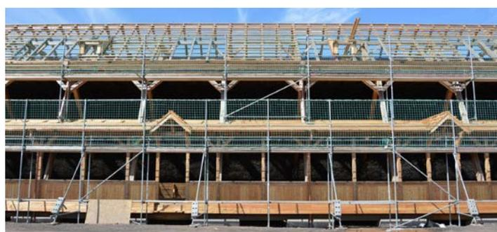
Über die gesamte Länge der Westwand und auf den Vordächern wurden die Dachlatten aufgebracht. Auch die Fallrohre sind angeschlossen. Sobald die Ziegel-Lieferung erfolgt ist, steht der Eindeckung der Westwand nichts mehr im Wege..
