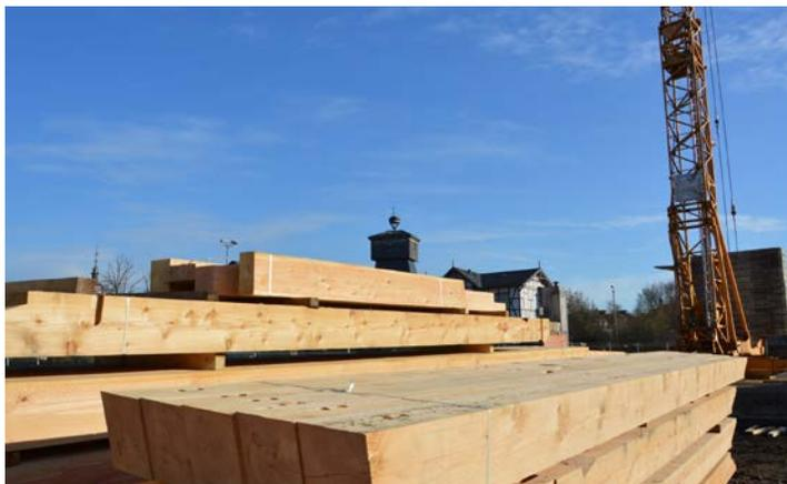
Bevor der Aufbau begann, wurden die Achsen der Höhen- und Längenmaße bestimmt. Anfang März rückte der Kran an. Unmittelbar danach erfolgte die erste Holzlieferung. Jetzt liegen die ersten Schwellen. Sie bilden wieder den unteren Part der Holzkonstruktion und liegen längs zur Wand-Ausrichtung. Hier sitzt später die gesamte übergeordnete Holzkonstruktion auf. Sie ist durch Anker mit den Beton-Fundamenten verbunden.
