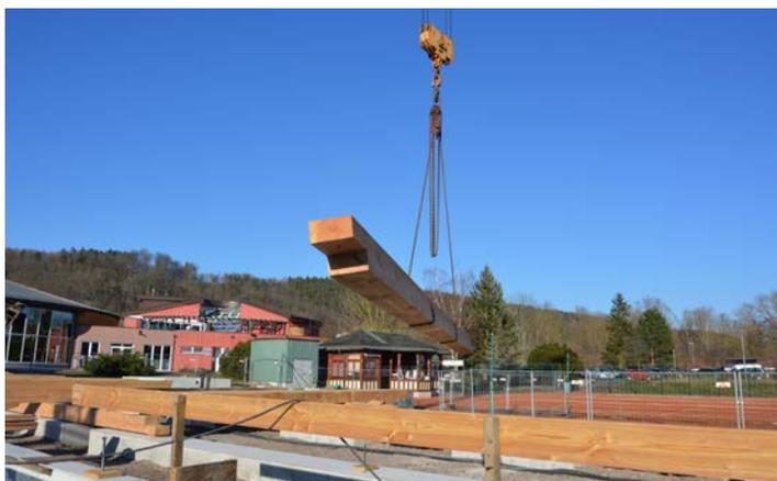
Zahlreiche Einzel-Fundamente lassen erkennen, dass die Ostwand im Querschnitt breiter ist. Deshalb werden an der Ostwand sechs Schwellen verbaut. Bei ihrer westlichen „Schwester“ wurden hingegen nur vier benötigt. Auch erste Grundbalken wurden darüber aufgebracht. Sie verlaufen quer und werden aus zwei Balken zusammengefügt. Wie zuvor bei der Westwand wird sich bei der Ostwand stark am historischen Vorbild angelehnt. Regelmäßig treffen bereits Reisig-Lieferungen für den späteren Einbau ein.
