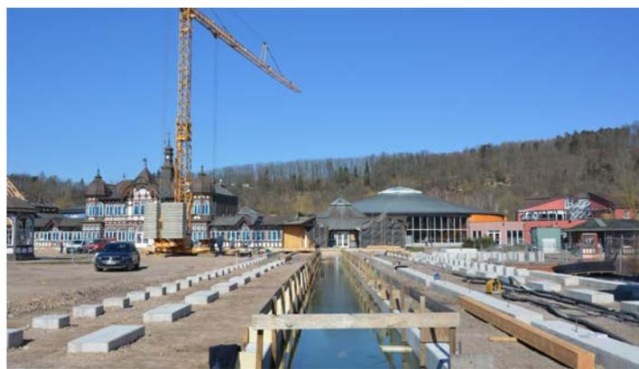
Die Zugänglichkeit der Ostwand ist von Norden und Osten eingeschränkt. Deshalb muss der neue Kran eine entsprechende Reichweite haben. Darüber hinaus wird er von kleineren Helfern unterstützt. Er bekommt später einen mobilen Kran zur Seite gestellt. Zudem wird eine Teleskop-Arbeitsbühne auf der Tennisplatz-Seite eingesetzt. Für die Ostwand wird etwa 1/3 Holz mehr benötigt. Insgesamt wird für beide Wände eine Holzmenge von etwa 750 Kubikmetern verbaut.
