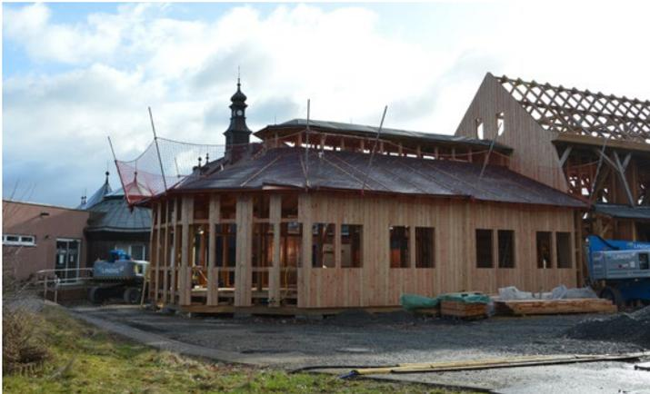
Nachdem die Holzkonstruktion des westlichen Brunnenhauses steht, bekommt es nun seine äußere Hülle. Auch der Süd- und der Nordgiebel der Westwand werden verschalt. Wie zuvor bei den Vordächern der Westwand, wurde auf dem Dach des Brunnenhauses ein Wetterschutz aufgebracht. Diese Folien werden ebenfalls wieder weichen, sobald die endgültige Dacheindeckung mit Tonziegeln erfolgt.
