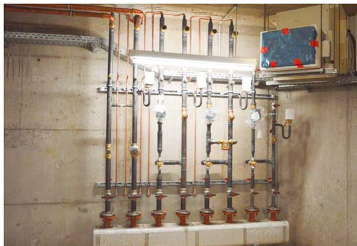
Vom Baustellen-Besucher unentdeckt sind die Fortschritte im Keller des Mittelbaues. Hier wird am Heizungs- und Lüftungssystem gearbeitet. Im Bereich der Inhalation wurden sämtliche Abgänge am Heizkreisverteiler erneuert. Zudem soll der alte Heizkreisverteiler des Gastronomie-Bereiches erneut werden. Ein neues Modell wurde geliefert und wird demnächst angeschlossen.
