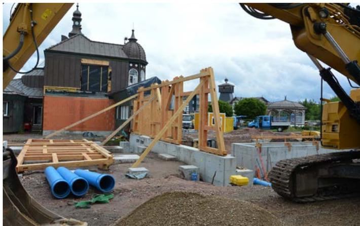
Die Gründungsarbeiten an der Westwand sind abgeschlossen. Sowohl die Giebel-Fundamente als auch die letzten Einzel-Fundamente zur Gartenseite sind fertiggestellt. Jetzt ist die nächste Bau-Phase erreicht: Der Holzaufbau läuft!
