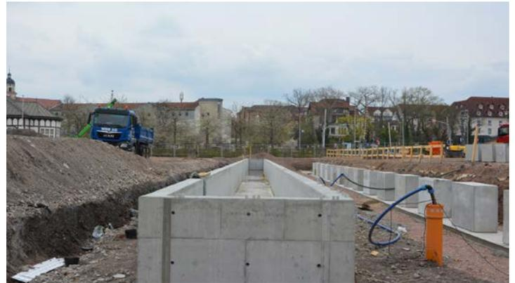
Parallel zur Solewanne sind zwei Magerbeton-Streifen geplant. Einer davon wurde bereits gefertigt. Auch auf diesen werden quaderförmige Einzel-Fundamente platziert. Derzeit werden die Betonquader in Schalungsformen auf der Baustelle gegossen. Auch in ihnen stecken Bewehrungsstahlgitter. Die Einzel-Fundamente werden nach und nach auf die Betonstreifen gesetzt. Sie tragen später die Holzkonstruktionen der Laubgänge an den Reisig-Wänden.
